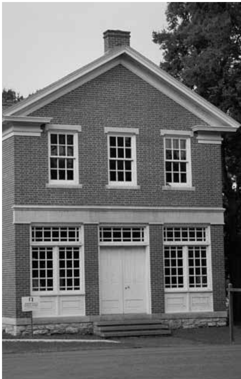
Il negozio di mattoni rossi di Nauvoo. Questo edificio servì da ufficio del profeta Joseph Smith e come attività commerciale per aiutarlo a mantenere la famiglia. Molte riunioni e attività sociali della Chiesa si tennero nel negozio.
